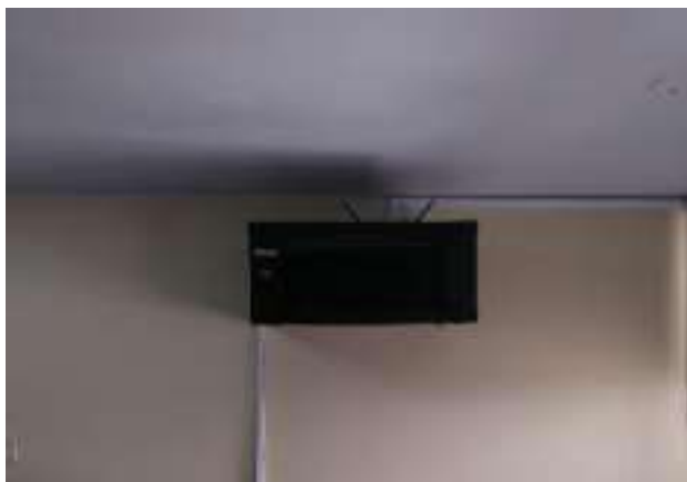
Foto 14. Gabinete rack de comunicaciones principal de la red de la contraloría.
